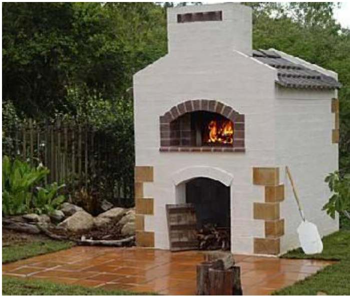
Fig. 12.3 Cuptor cu încălzire directă a camerei de coacere
